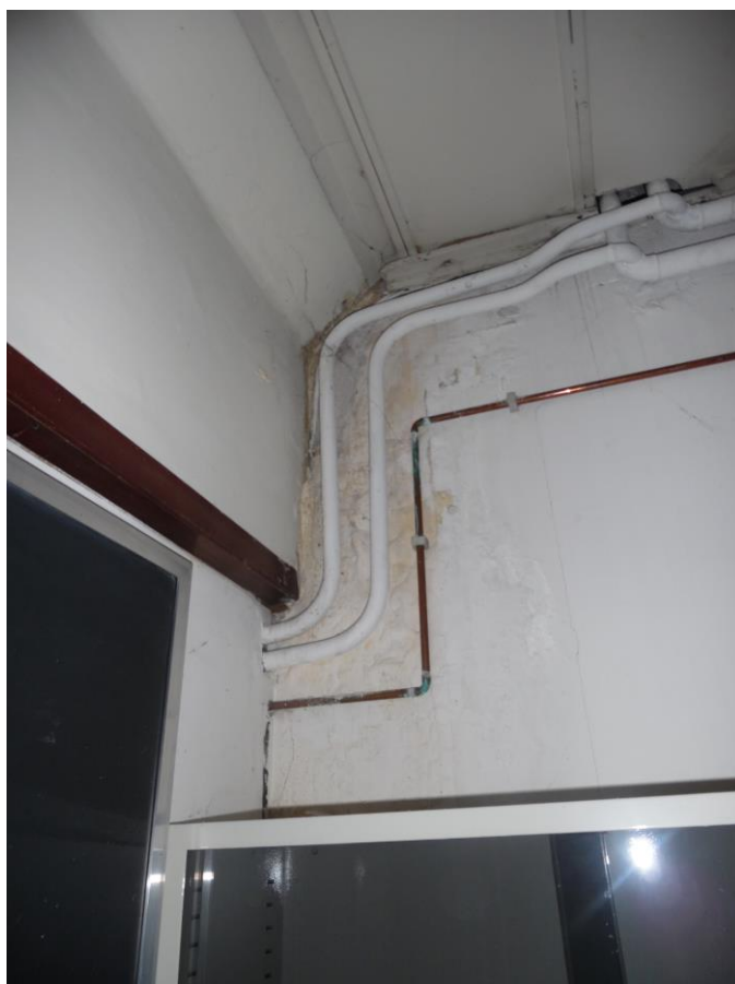
Umidità di risalita muratura esterna a Sud ed Est
