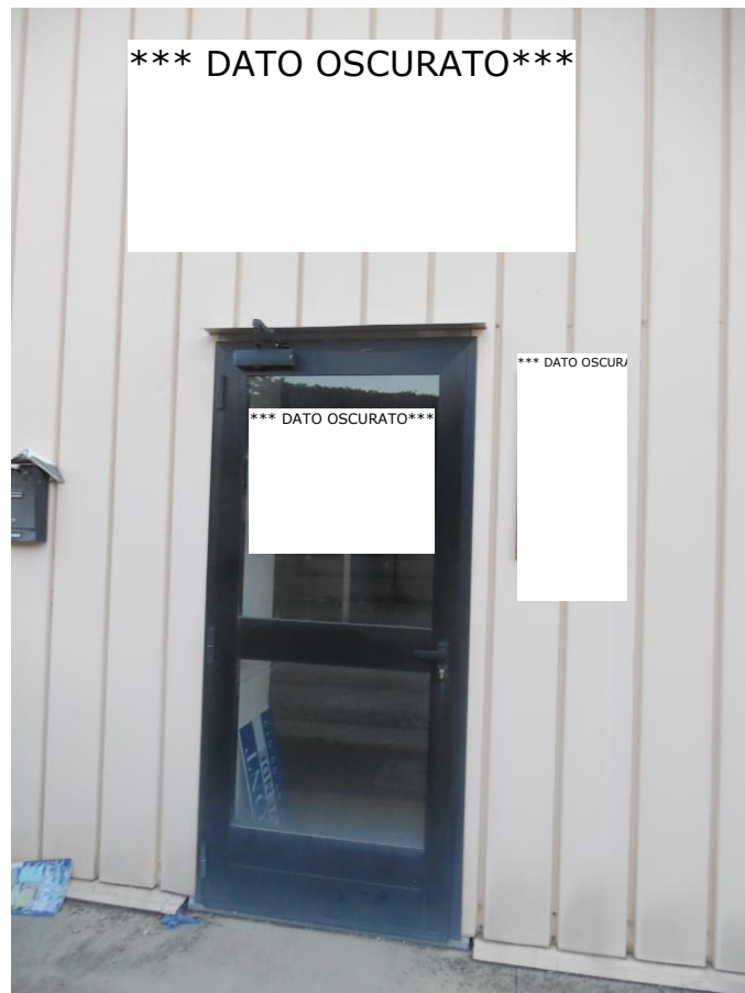
Ingresso – vano scale – p.T
